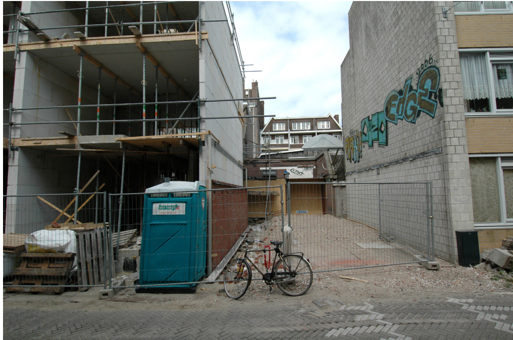
8 Het onbebouwde perceel Rozenstraat 194, situatie augustus 2008. De recente nieuwbouw aan weerszijden van het plangebied heeft de ondergrond deels verstoord
